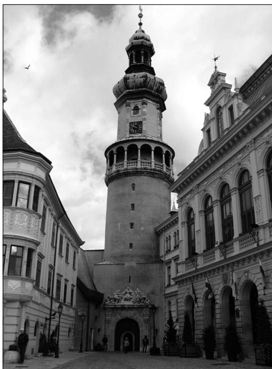
4. ábra: A Tűztorony a rekonstrukció előtt
