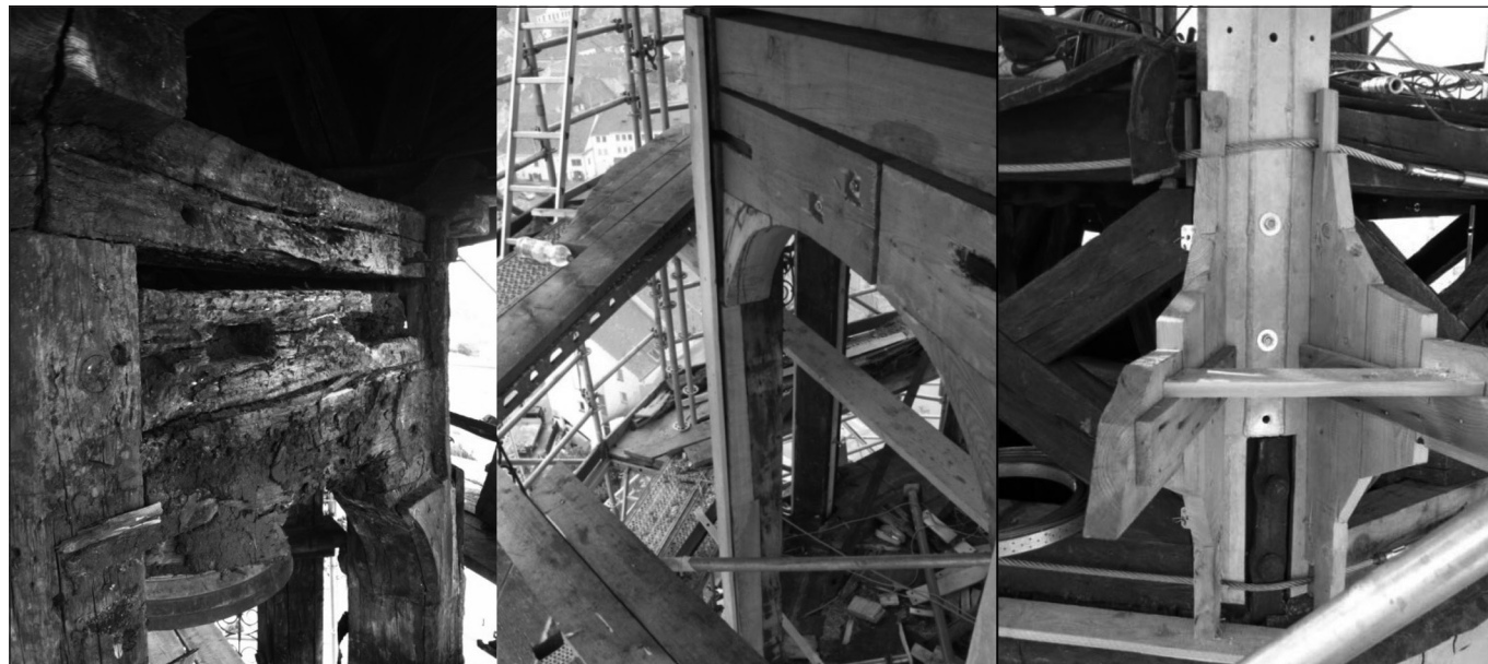
20. ábra: A harangszinti ötszög keresztmetszetű oszlopokat megerősítő acélszerelvény és a kicserélt poligonális gyűrű egy része
